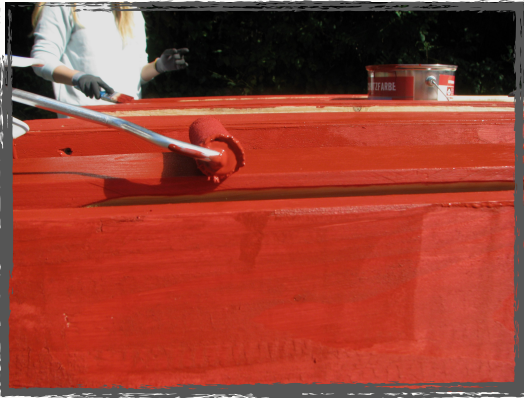
Bestreichen der geschliffenen Europaletten mit Wetterschutzfarbe. Mittlerweile wachsen hier verschiedene Kräuter!
